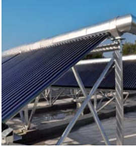
Vakuum-Röhrenkollektor für solarthermische Großanlagen
