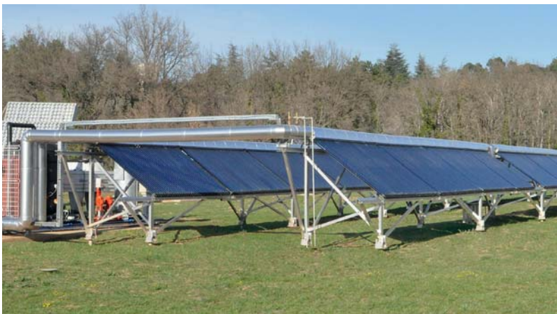
Die Vakuum-Röhrenkollektoren eignen sich zur Freilandaufständerung oder können auf Flachdächern montiert werden.
