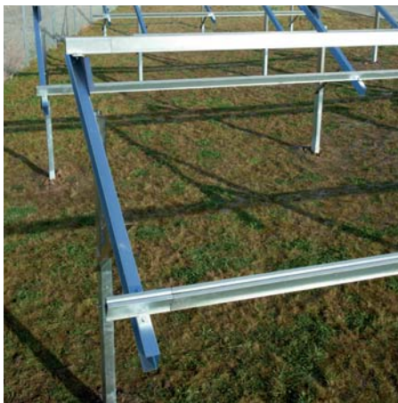
Unterkonstruktion zur Aufnahme von Vitosol 200-T
